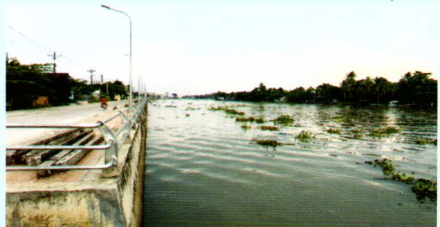
Bờ kè sông Ô Môn (quận Ô Môn, TP Cần Thơ) đã xây dựng hoàn thành, khắc phục sạt lở, ổn định bờ sông
